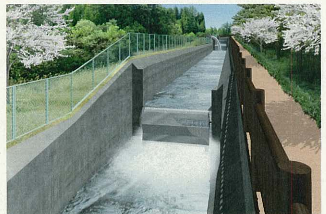
写真4 チロリアンクロスフロー水車
