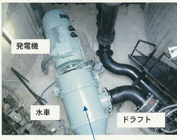
写真3 横軸円筒型フランシス水車
